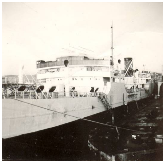
Bildet viser M/T Gallia med åpne tanklokk.
